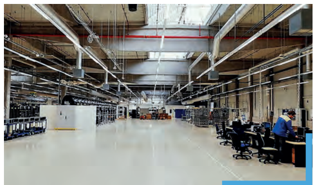
Jednotlivé okruhy svítidel jsou řízeny pomocí sběrnice DALI (komunikační protokol pro osvětlení)
